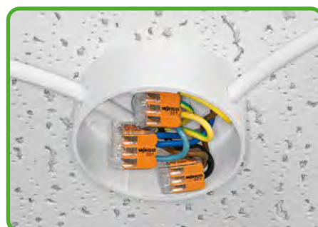
Leuchtenverteilung in Deckenbaldachin
