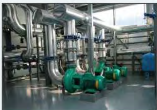
ОВК и водоснабжение
