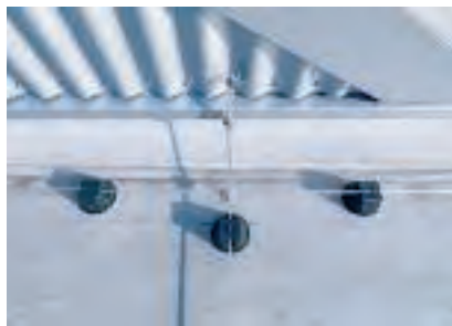
Соединение металлического фасада с системой молниезащиты
