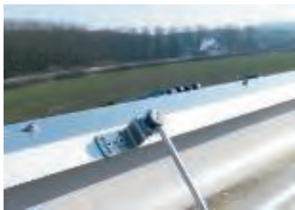
Соединение аттика с системой молниезащиты
