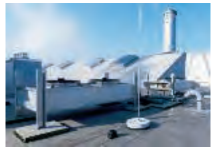
Изолированная молниезащита для кровельных надстроек
