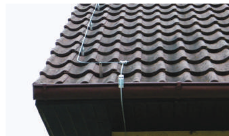
Скатные кровли Создание молниеприемной сетки на скатных кровлях
