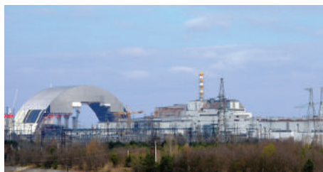
Чернобыльская АЭС, ХОЯТ-2, г. Чернобыль
