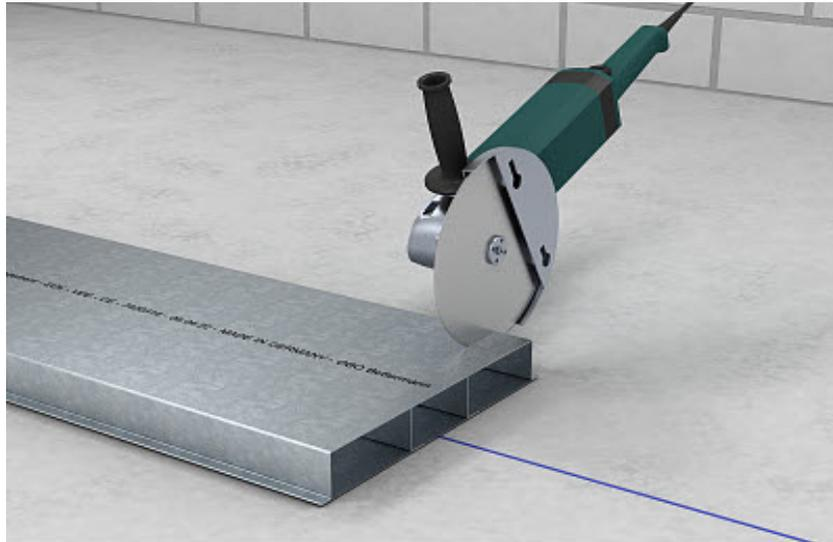
Die Stahlblechkanäle lassen sich am einfachsten mit einem Kompakt-Winkelschleifer bearbeiten. Es ist darauf zu achten, dass die Schnitte sauber ausgeführt werden. Anschließend muss eine Entgratung der Schnittkanten erfolgen. Dies ist für die spätere Verlegung der Kabel und Leitungen wichtig, um Isolationschäden zu vermeiden.
