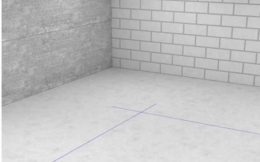
Die geplanten Kanalwege sowie die Kreuzungspunkte und relevanten Stellen für Zug- und Abzweigdosen bzw. Gerätedosen werden vorab auf dem Boden z. B. mit Lasermess-Einrichtungen oder einer Schlagschnur übertragen.
