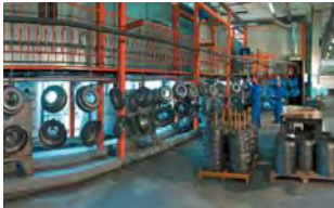
Цех порошковой покраски
