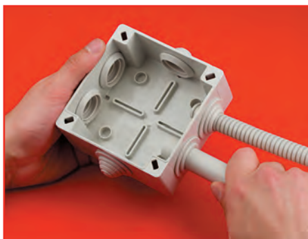
2 этап. Ввод гофрированной и жесткой трубы
