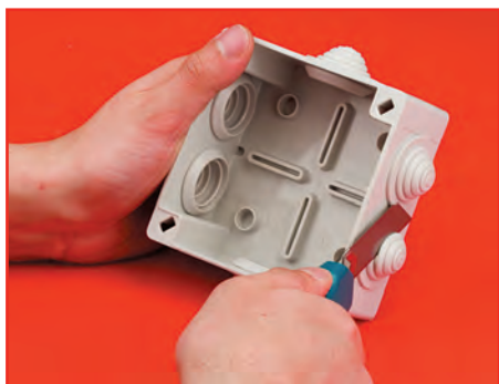
1 этап. Срезаем кабельный ввод
