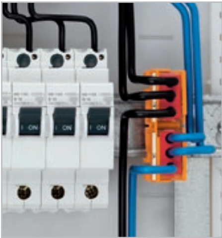
Подключение одножильных и многожильных проводников 6 мм 2 /AWG 10.
