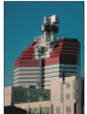
Thermoplus, Бизнес-центр, Гетеборг (Швеция)
