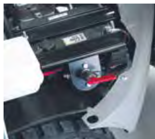
16 Главный выключатель питания
