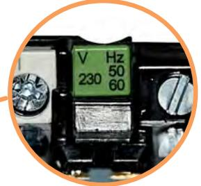
→ Диапазон напряжения управления при 220 V AC: от 0,85 до 1,15 x Us; нижняя граница в соответствии с IEC 60947
