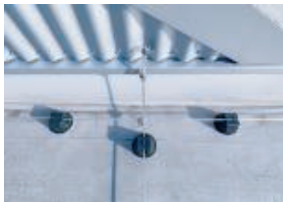
Соединение металлического фасада с системой молниезащиты
