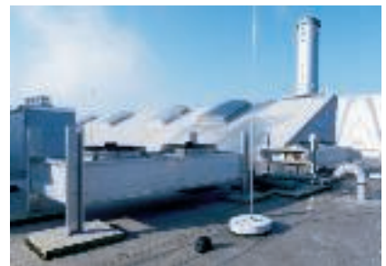
Изолированная молниезащита для кровельных надстроек
