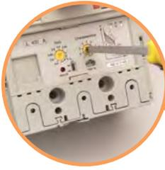
→ У автоматических выключателей с электронным расцепителем уровень защиты от перегрузки регулируется в диапазоне от 0,4 до 1 x In. Выбор электромагнитной защиты осуществляется из 7 предустановленных характеристик
